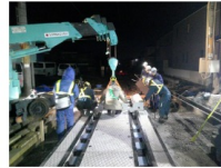
夜間作業（連続軌道ブロック敷設）
